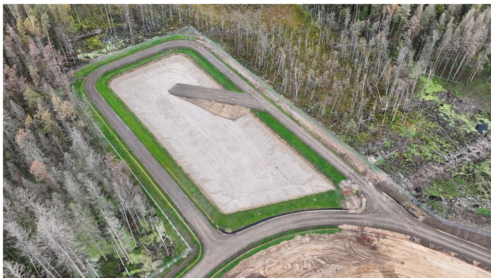
2024 m. įrengta nauja asbesto turinčių atliekų šalinimo sekcija
